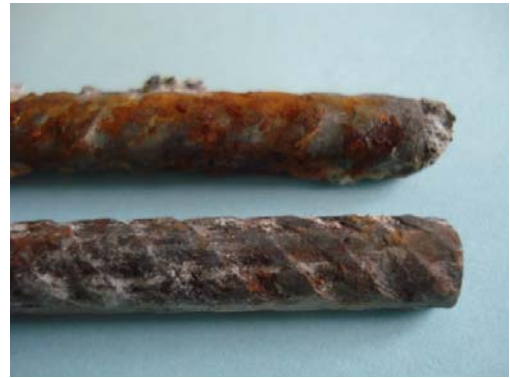
Bild 5.35b Korrosionsklasse 1 (unten) und 2 (oben).
