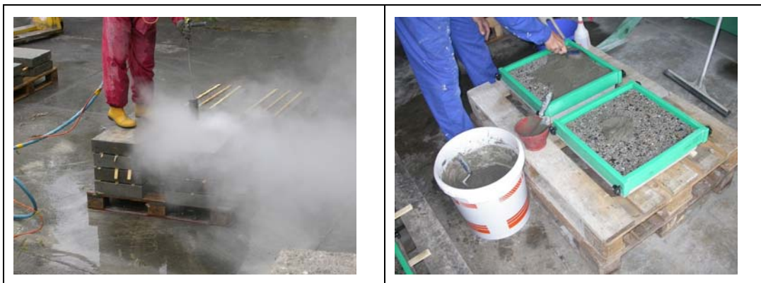
Abb. 4.3 Untergrundvorbereitung und Reprofilierung.
