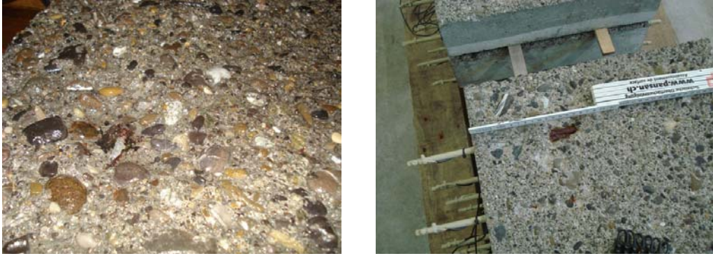
Bild 5.4 Aufgeraute Oberfläche der Grundkörper mit sichtbarer Korrosion.
